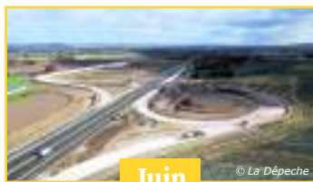
Début des travaux de l'échangeur autoroutier
