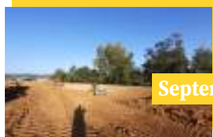
Début des travaux du lotissement Petit roubis
