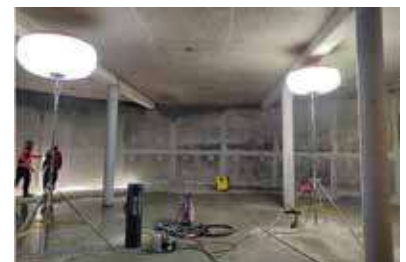
Vue de l'intérieur de la nouvelle cuve
