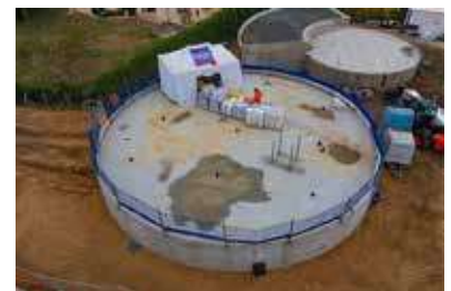
Vue de la nouvelle cuve par drone
